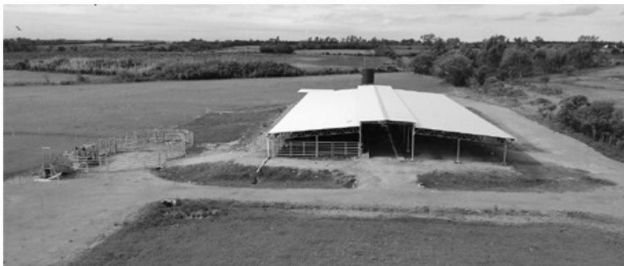
– Vista del Feedlot en Villa Haydee, Se trata de un sistema 100% techado con piso de hormigón. En la actualidad funciona solamente una batería de corrales (a la izquierda de la imagen), con capacidad para 120 animales distribuidos en 3 corrales de 40 cabezas cada uno.
